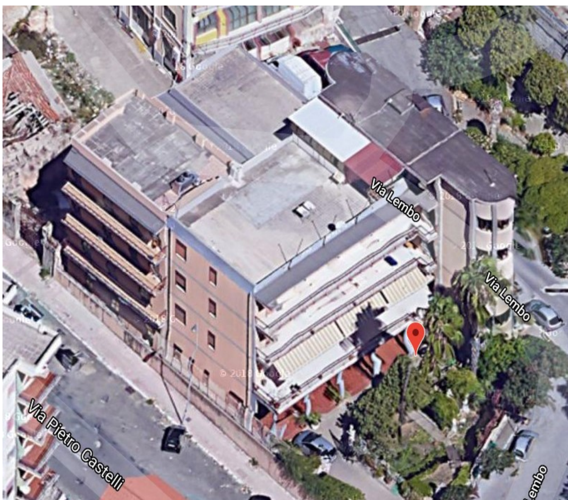
Figura 7 - Foto aerea edificio 3 "Casa di cura"
