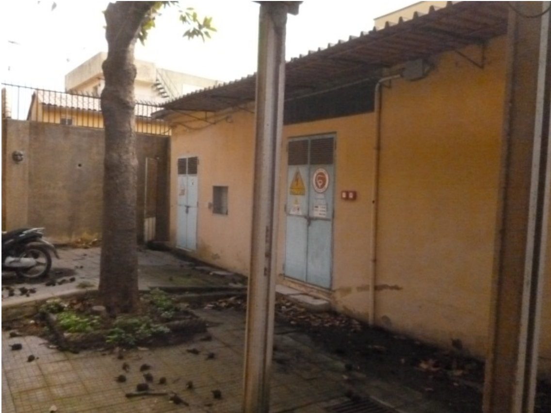
Figura 30 - Locali tecnici da bonificare
